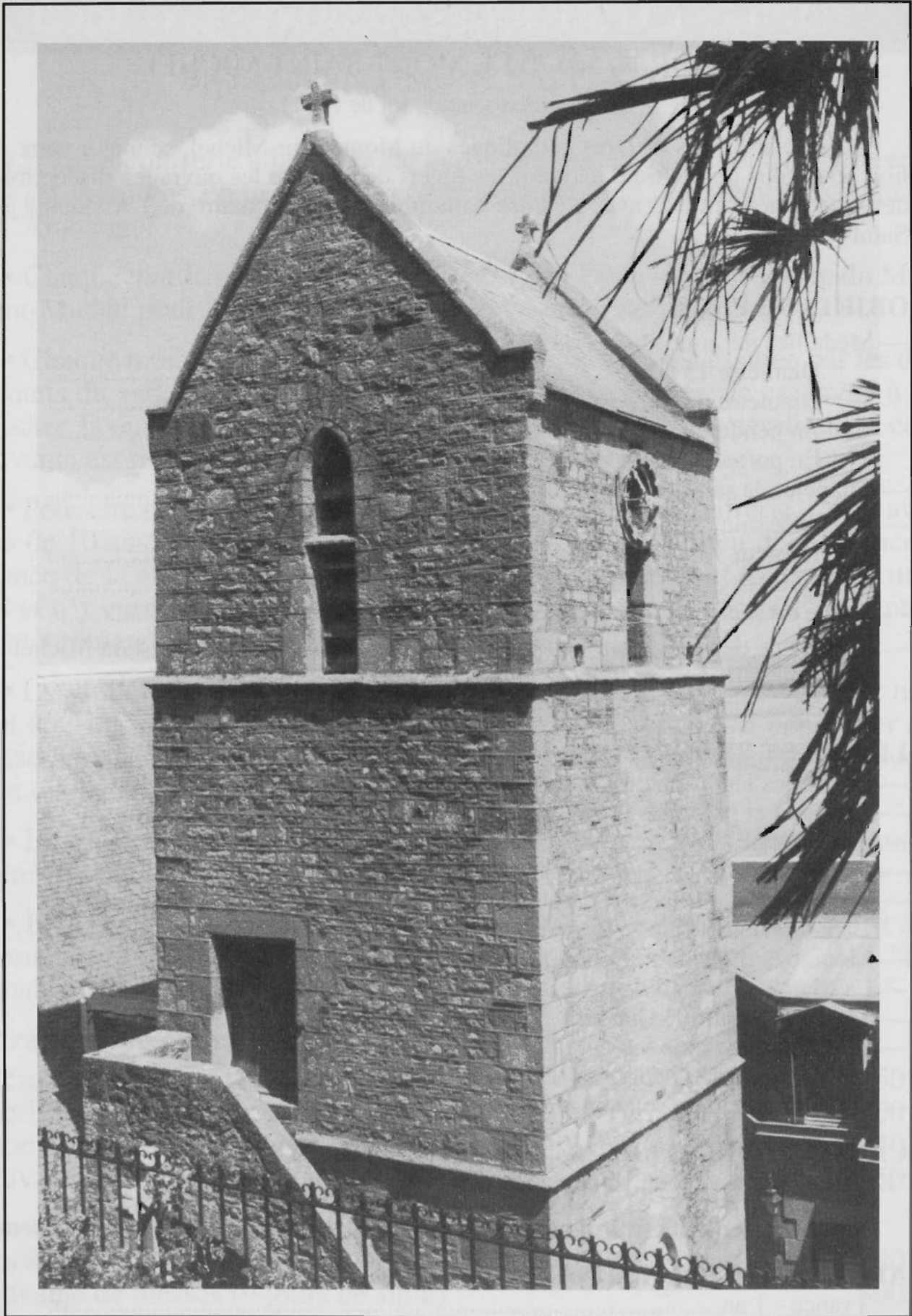
Vue du clocher de l'église paroissiale du Mont Saint-Michel
