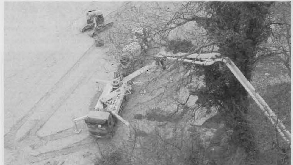
*Vue de la bétonnière télescopique pour amener le béton pour la dalle du plancher de la salle de réunion. (Longueur du bras télescopique : 30 m !)*
