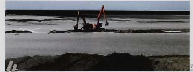
Pelleteuses au travail sur l'enrochement dans le lit du Couesnon
