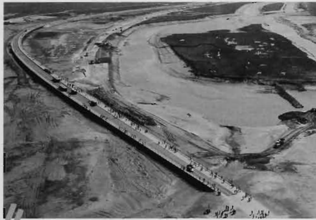
Le pont, le gué submersible en avril 2015 et l'épi de partage, à droite dans le Couesnon
