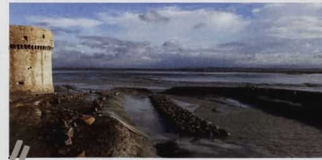
Enrochement à l'Est du Mont, pour protéger les remparts
