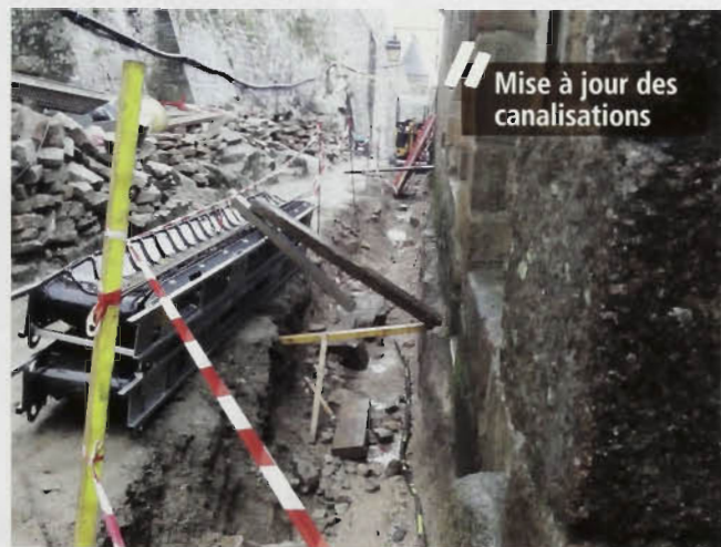
Une fois mise à nue, on fait passer les nouveaux réseaux...
