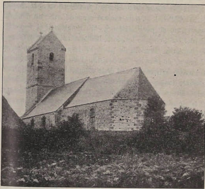
ÉGLISE DE BEAUVOIR (MANCHE)
