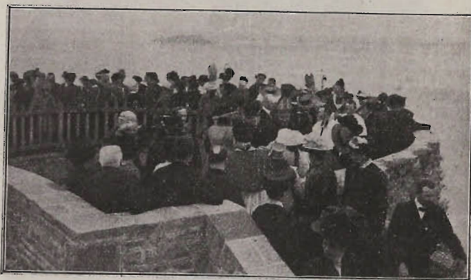
SUR LA TOUR DU NORD
