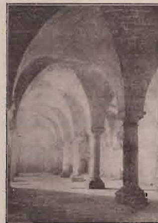
L'Aumônerie, deuxième salle dite « Montgomerries »
