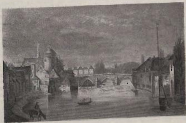
Château et vieux pont de Laval
