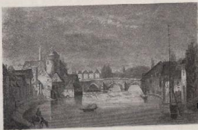
Château et vieux pont de Laval
