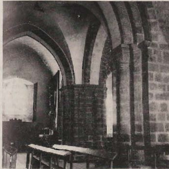
Piliers et colonnes de Robert de Thorigny (1157)
