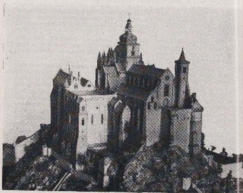
Élevée à la croisée nef-chœur-transepts, la tour-lanterne domine le dortoir attenant au bas-côté Nord de l'église
