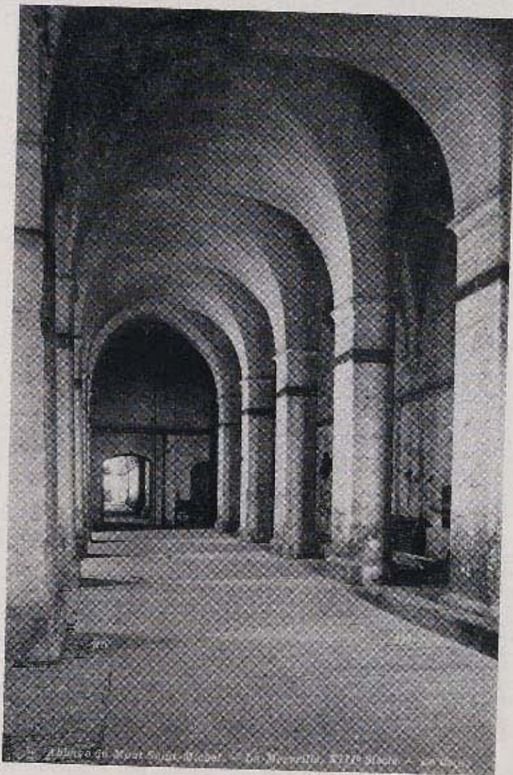
Le Cellier, construction utilitaire sans prétention décorative : les colonnes de l'Aumônerie sont remplacées par des piles carrées, sans chapiteaux sculptés. Les voûtes d'arêtes sont pourtant bien semblables.
