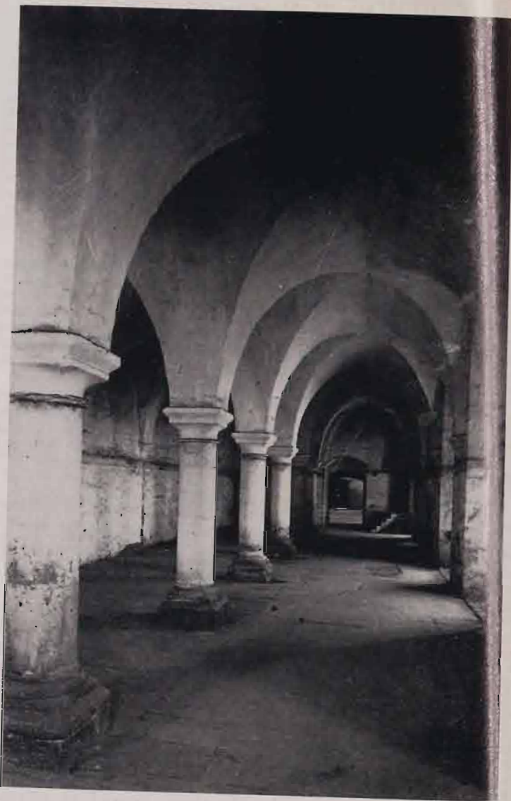
L'Aumonerie, ou salle des aumônes, est composée de deux nefs. Les voûtes d'arêtes, de forme ogivale, reposent sur une épine de fortes colonnes dont la base et le chapiteau sont carrés... Au fond de la salle, une ouverture la fait communiquer à niveau avec le cellier.
