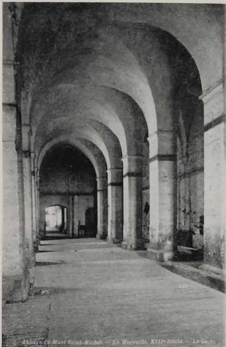
Le Cellier, construction utilitaire sans prétention décorative : les colonnes de l'Aumônerie sont remplacées par des piles carrées, sans chapiteaux sculptés. Les voûtes d'arêtes sont pourtant bien semblables.
