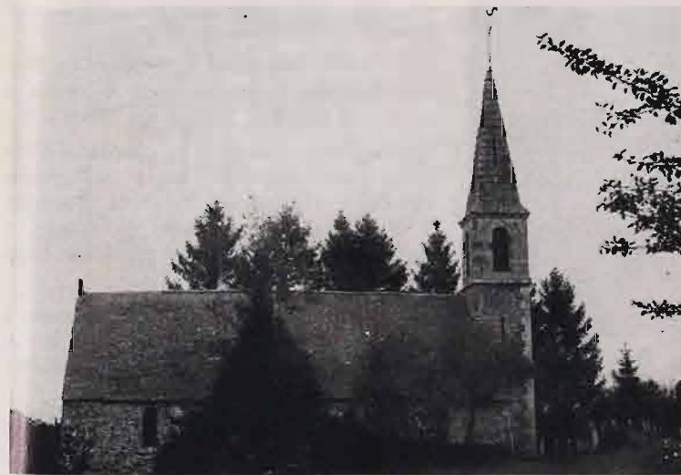
Chapelle du Pont-Aubrée
