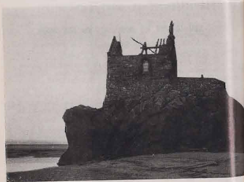
Dépose de l'ancienne charpente
