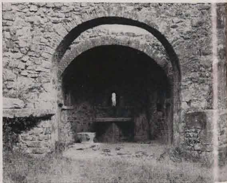
Chapelle Saint-Michel de Lestre, vue de l'intérieur (Cl. Le Goubey)
