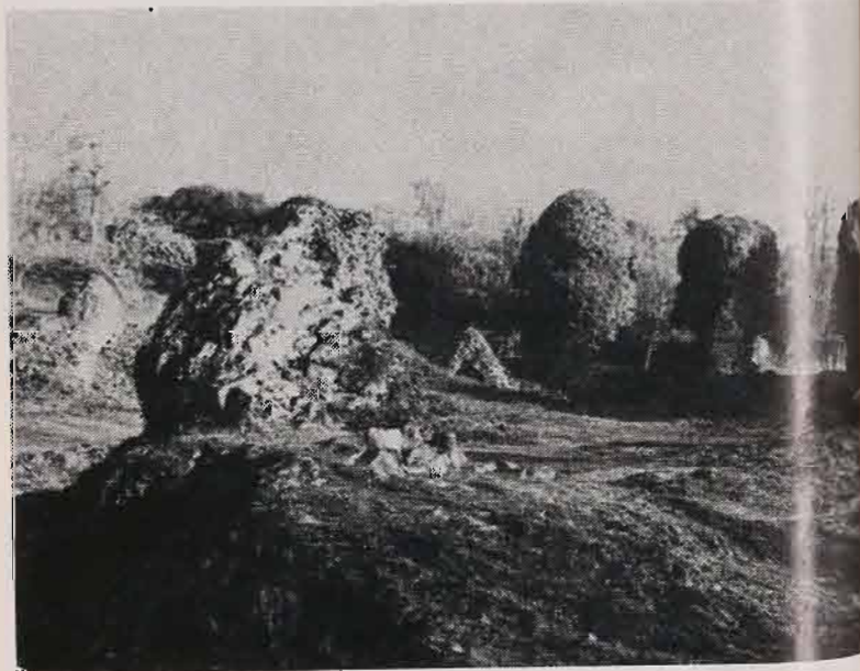
Etat des ruines du chœur de l'Abbatiale (avant les travaux de septembre 1970)
