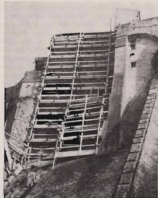
L'échafaudage de vingt-cinq mètres devant la chapelle Saint-Etienne
