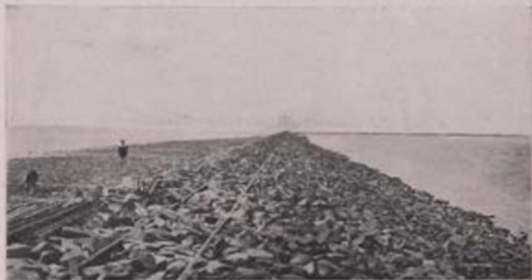
LA DIGUE SUBMERSIBLE DE ROCHE-TORIN Vue prise sur la digue même
