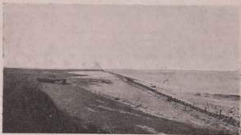
LA DIGUE SUBMERSIBLE DE ROCHE TORIN Vue prise sur le talus Nord du remblai.
