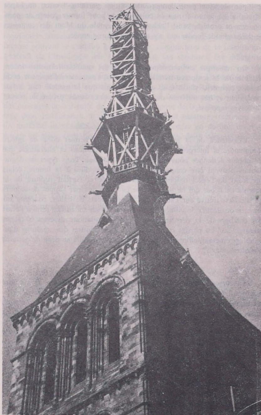
*Échafaudage monté en 1936 à partir du lanternon pour l'accès aux parties supérieures de la flèche et vérification des fixations de la statue de l'archange. (Archive de l'auteur.)*
