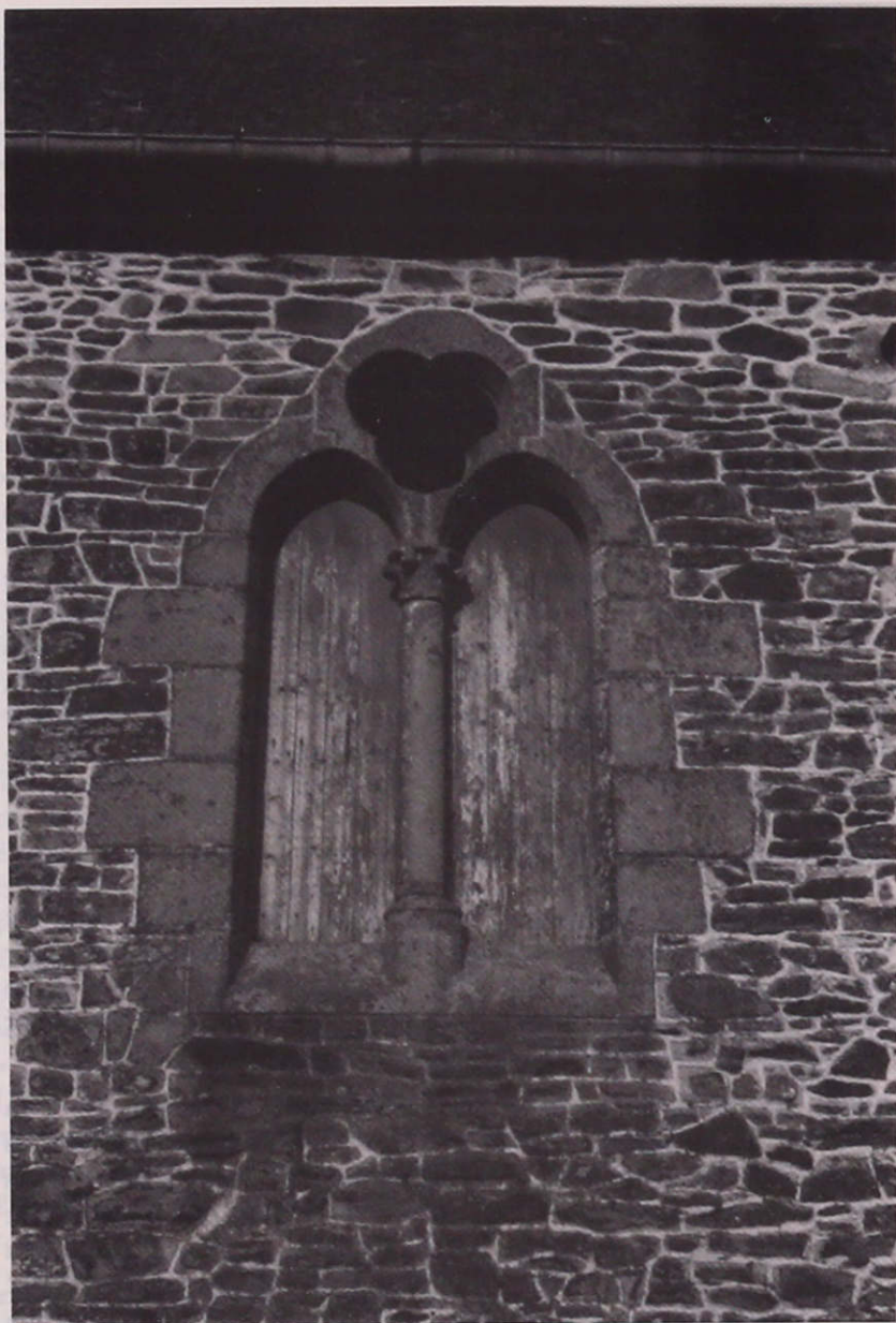
Une des trois fenêtres du premier étage du logis Nord. Chapiteau et base comparables à ceux du Réfectoire des Moines du Mont-Saint-Michel, suggérant que le bâtiment fut construit à la fin de l'abbatit de Raoul des Isles (1212-1228).
