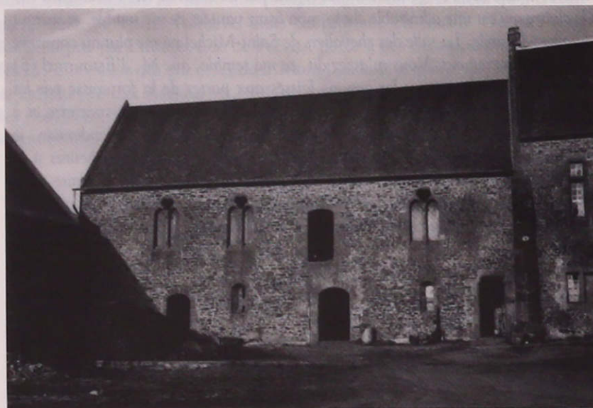
Façade Ouest du logis Nord : notez les trois fenêtres du premier étage, la quatrième a été remplacée par une porte.
