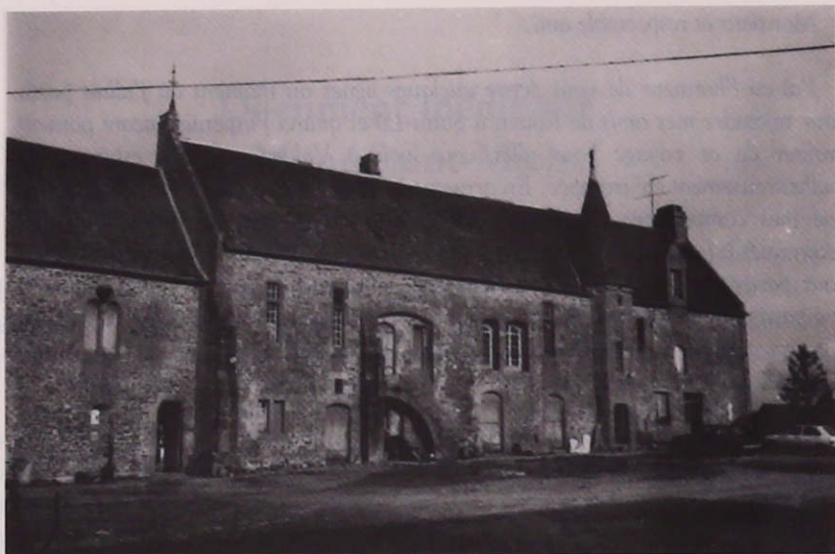
Vue générale du grand bâtiment Est depuis le Nord-Ouest. A gauche, le logis Nord, datant des environs de 1225 (phase III) ; à droite, logis du XV e siècle (phase VIII) ; au premier étage, portes donnant autrefois sur une aile en retour.
