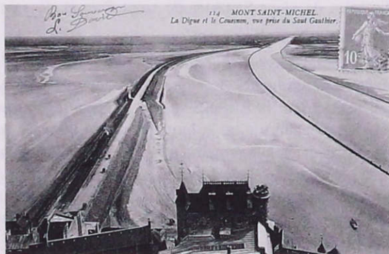
La digue et les cordons de pierres guidant le cours du Couesnon (vers 1910)
