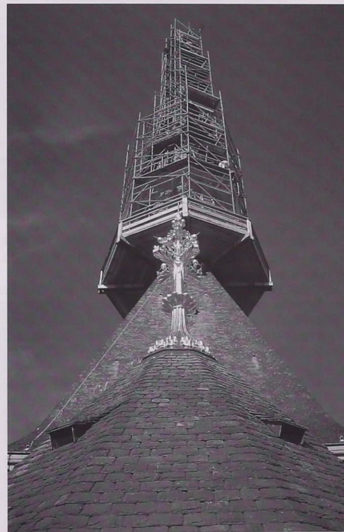
La flèche échafaudée, le 1 er juin 2002.
