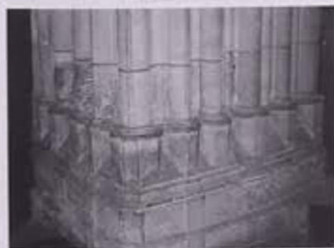
Fig. 11a: Evreux détail d'une pile du chœur (cliché Y. Gallot)
