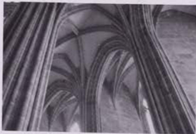
Fig. 3a: Mont-Saint-Michel, piers du chœur (cliché P. Techer)
