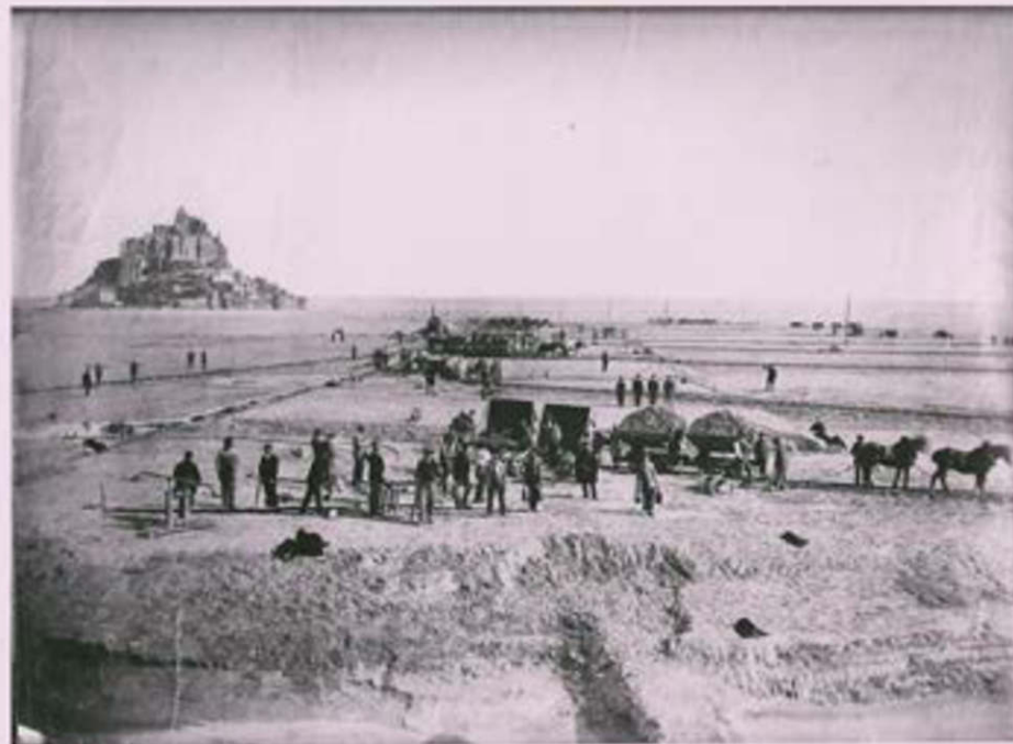
Rare photo de la construction de la digue insubmersible du Mont-Saint-Michel, en 1878.
