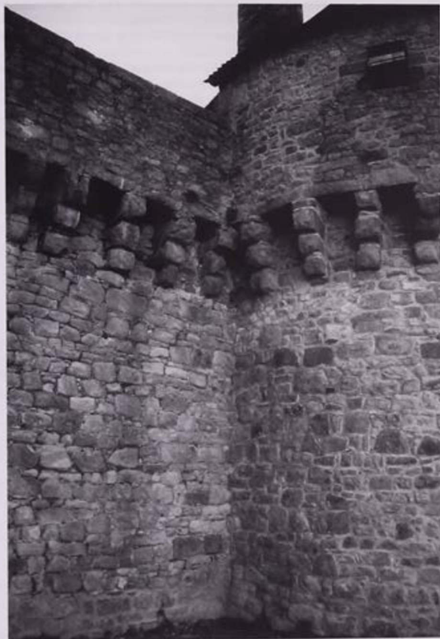
Figure 12 - Mâchicoulis avec consoles composées de blocs de granite équarris conservés sur la Tour de l'Arcade et la courtine adjacente. Cliché : François Delahaye, INRAP.
