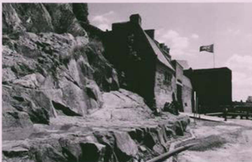
La face sud du rocher, contre laquelle doit être adossée la "plateforme de sécurité" ; c'est à cet emplacement que le rocher doit être coupé afin de créer un passage derrière le corps de garde des Bourgeois (à droite sur la photo).
