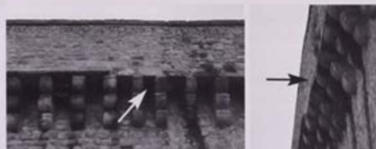
Figure 14 - Traces de l'emplacement de l'ancienne Tour Denis conservées sur le parapet de la courtine Tour de l'Arcade / Tour de la Liberté. Cliché : François Delahaye, INRAP.
