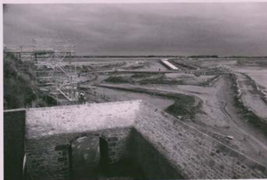
L'échafaudage construit en juillet-août 2013 pour couper le rocher et réaliser le passage reliant la plateforme de sécurité et la cour de l'Avancée
