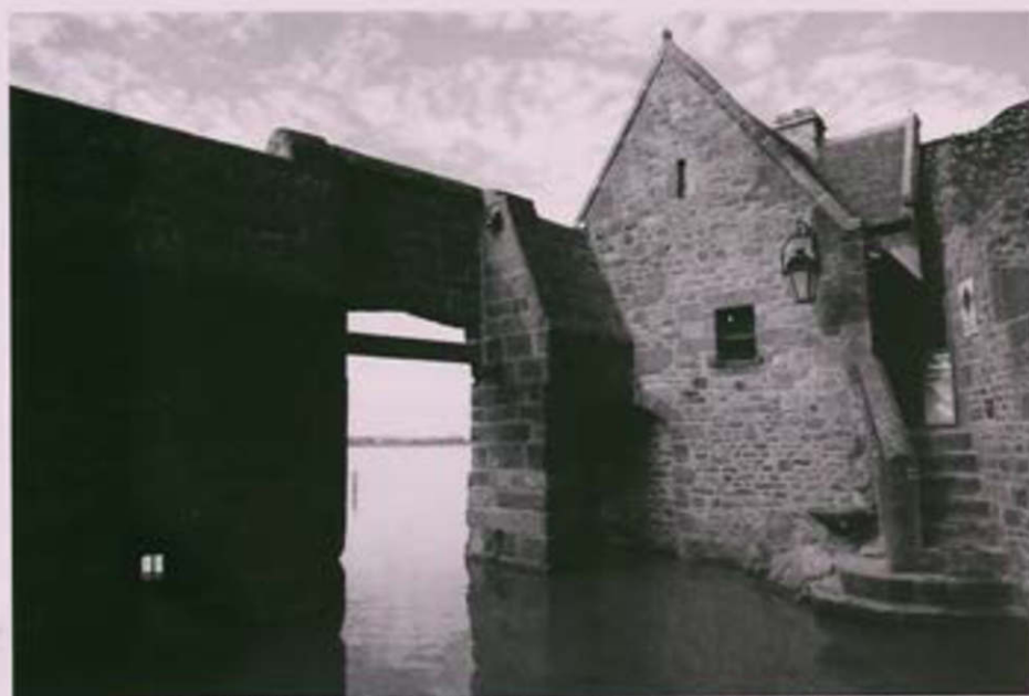
Corps de garde des Bourgeois (fin août 2013 - marée coefficient 108) derrière lequel le rocher doit être entaillé pour réaliser un passage entre la plateforme de sécurité et la cour de l'Avancée.
