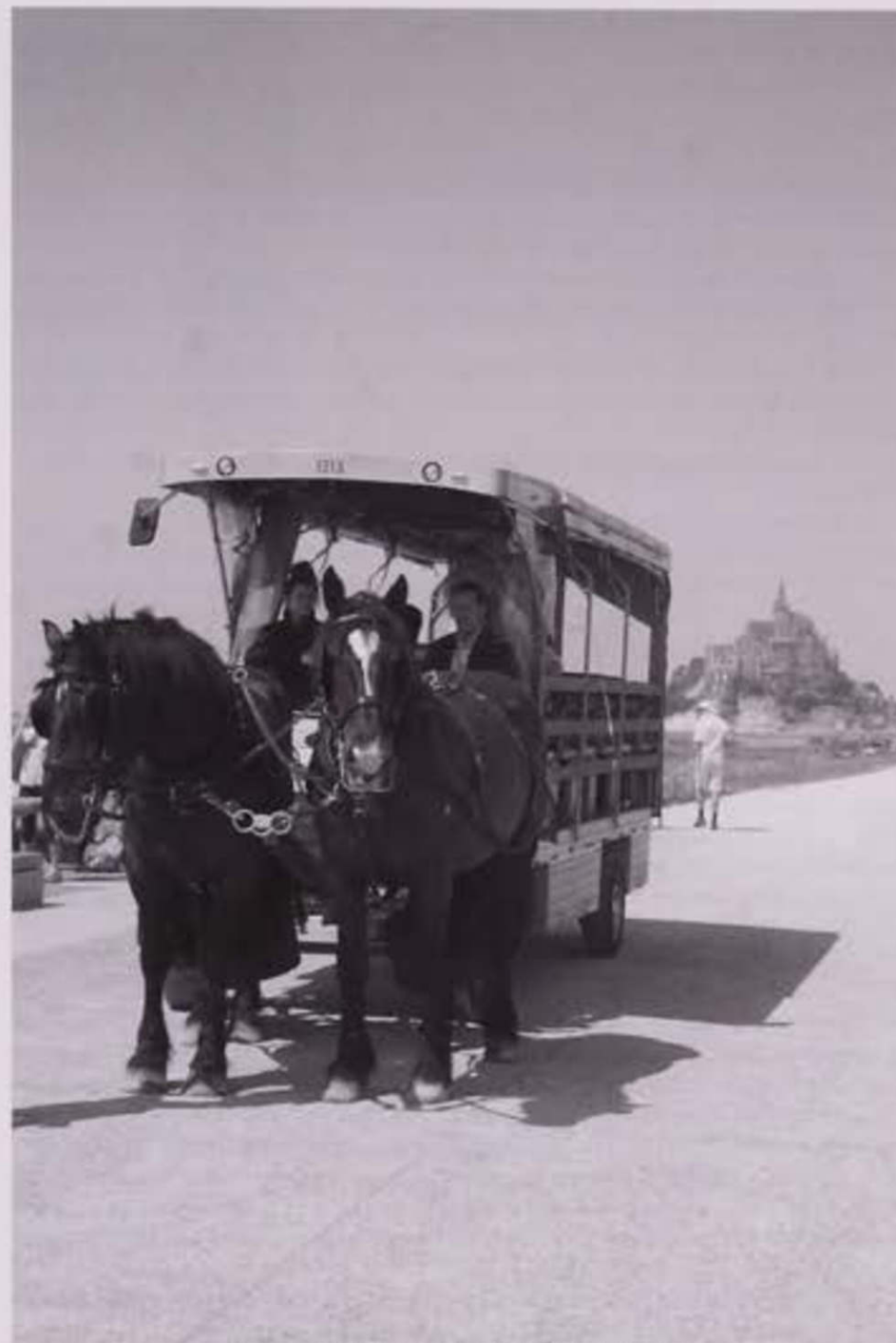
Une « maringotte » au niveau du barrage du Couesnon. Cliché Henry Decaux.
