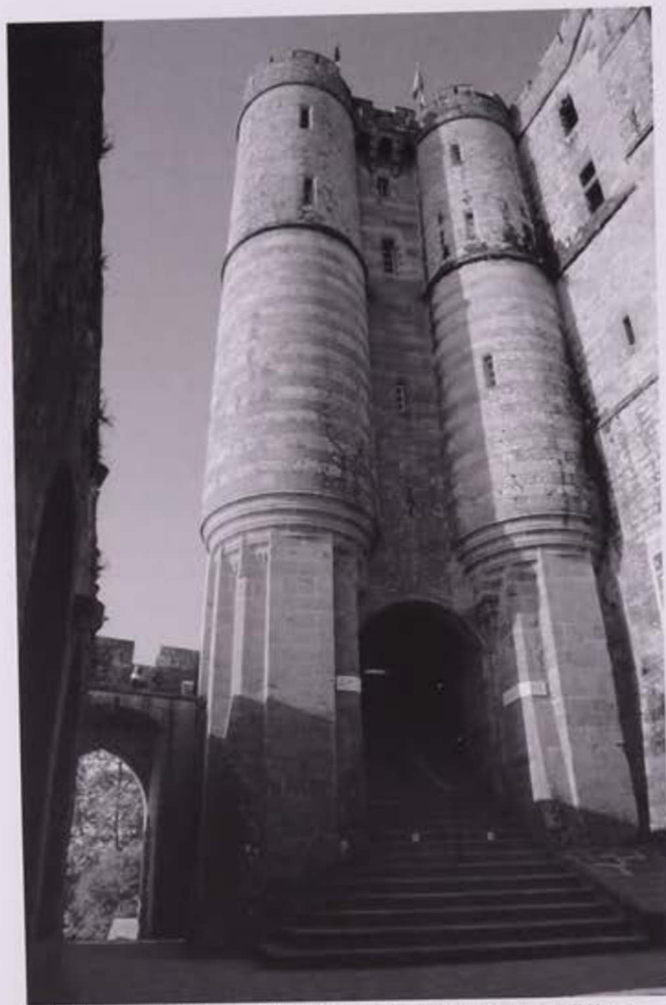
Le châtelet, élevé à la fin du XIV e siècle par l'abbé Pierre Le Roy pour défendre l'entrée de l'abbaye Cliché Henry Decaëns.
