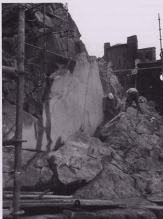
L'entaille du rocher pour créer un passage derrière le corps de garde des Bourgeois. Photo Amélie Saint-James
