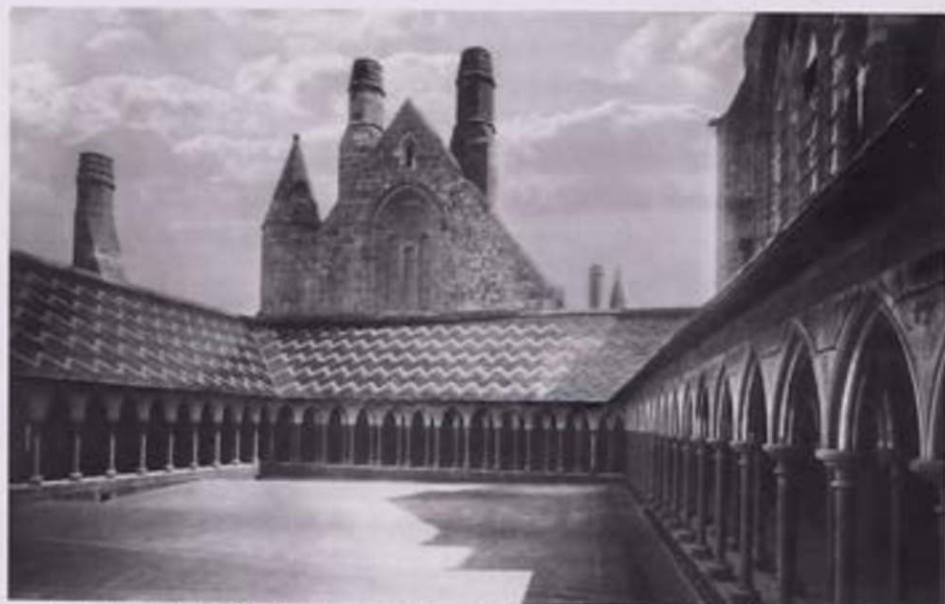
Le côté est du cloître vers 1900, après sa restauration par Edouard Corroyer - Coll. Henry Decaëns
