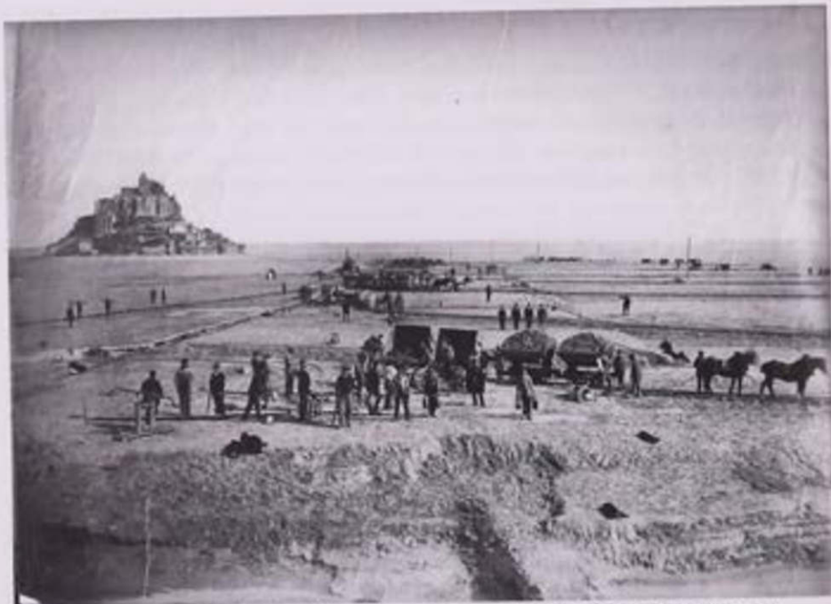
Photo anonyme de la digue insubmersible en cours de construction, 1878. Coll. H. Decaëns.
