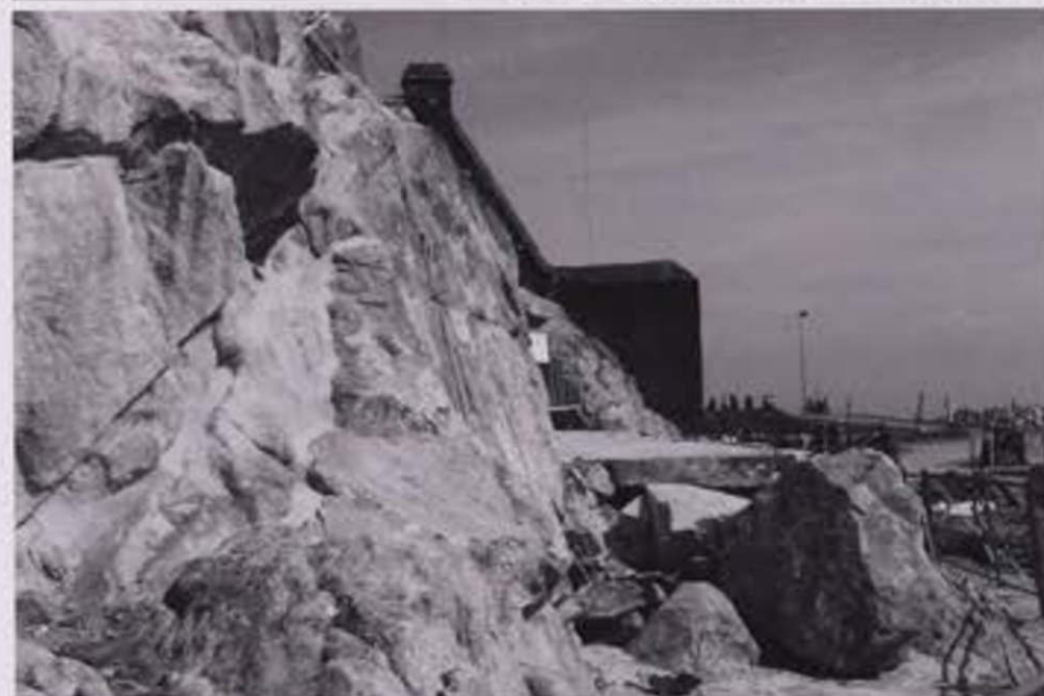
Le cheminement dans le rocher entre la future plateforme de sécurité et la cour de l'Avancée. Photo Henry Decaëns, 12 avril 2014
