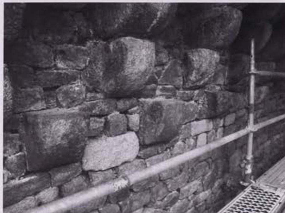
Fig. 3 Corbeaux mis en œuvre sous les consoles des mâchicoulis servant d'appui aux contre-fiches de l'échiffe.
