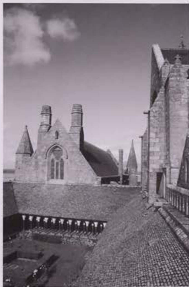
Vue d'ensemble du cloître et du réfectoire aujourd'hui. Cliché Henry Decaëns.
