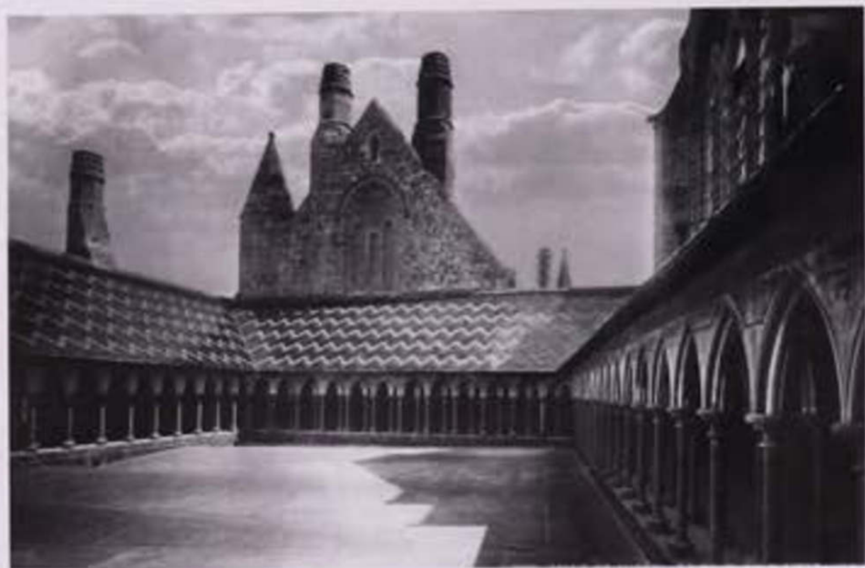
Vue d'ensemble du cloître vers 1900. Cliché C.N. & CO. Coll. Henry Decaëns.
