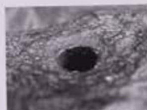
Détail d'une bombarde : on voit la lumière, trou communiquant avec la chambre à poudre de la culasse ; c'est par cet orifice que se faisait la mise à feu de la bombarde. Photo Jean-Luc Legros.
