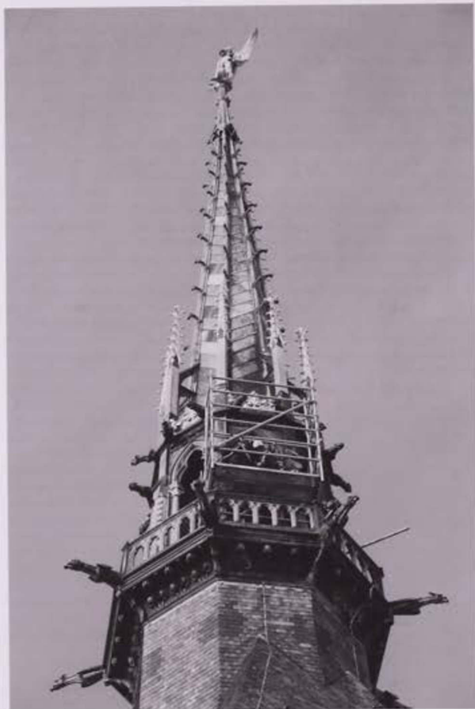
Photographie de la flèche prise le 28 janvier 2016 ; on commence seulement à monter l'échafaudage qui devrait permettre de déposer la statue de l'Archange le 25 février. Photo. Henry Decaëns.
