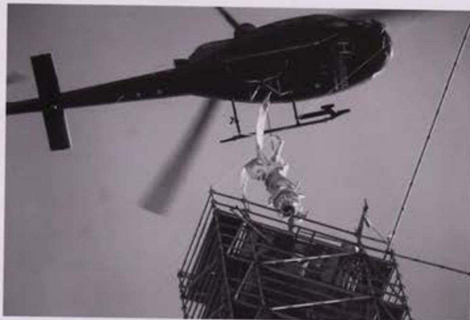
Mise en place au sommet de la flèche de la statue de l'archange de Frémiet, le matin du 26 mai 2016. Clichés H. Decaëns
