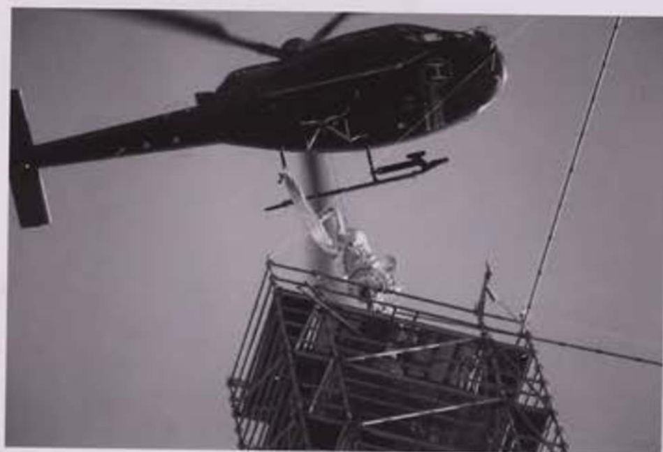
Mise en place au sommet de la flèche de la statue de l'archange de Frémiet, le matin du 26 mai 2016. Clichés H. Decaëns
