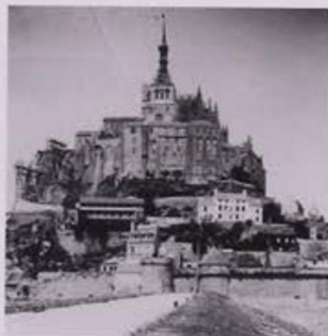
La flèche tout juste achevée : les charpentiers qui viennent de terminer leur travail ont mis un drapeau à l'endroit où la statue de Frémiet sera mise en place le 6 août 1897. Photo d'amateur, coll. Henry Decaëns.
