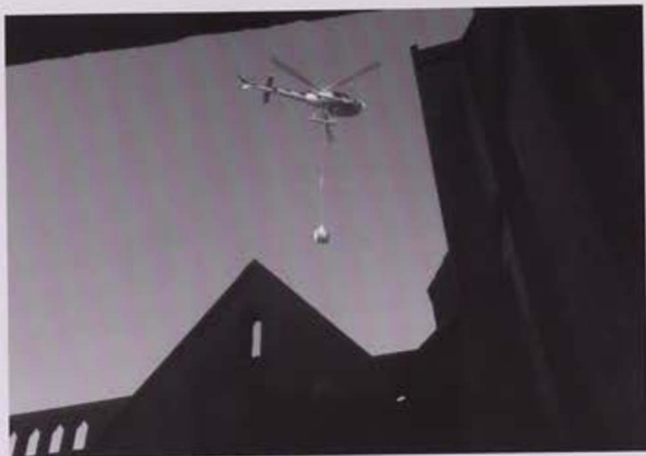
Transport des matériaux par hélicoptère, janvier 2017. Photo Françoise Denis
