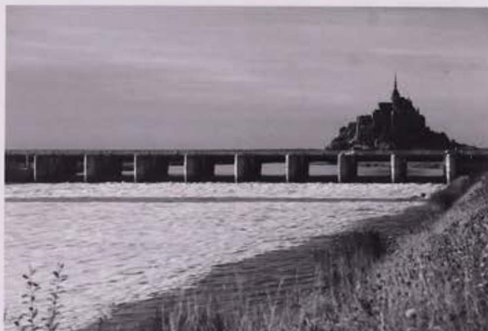
Vue du barrage de la Caserne : les portes sont abaissées afin de laisser passer l'eau de mer en amont ; cette eau stockée durant quelques heures est ensuite relâchée vers l'aval afin de créer un effet de chasse. Photo H. Decaëns, août 2015.
