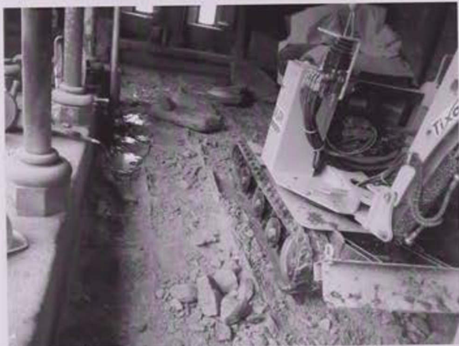
Un engin de chantier dans l'une des galeries du cloître en janvier 2017 (il a été hélitreuillé sur la plateforme de l'Ouest et amené dans le cloître par l'église) Photo Françoise Denis
