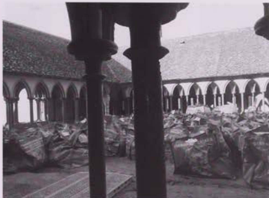
Les matériaux à évacuer sont mis en sac pour être hélitreuillés Photo Françoise Denis, janvier 2017
