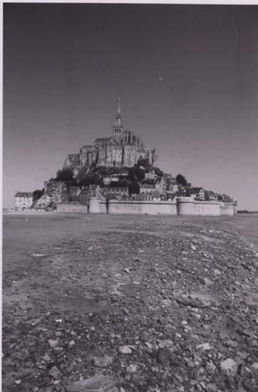
La face sud du Mont-Saint-Michel. Les travaux de rétablissement du caractère maritime ont permis de dégager et de mettre en valeur les remparts du village. Cliché H. Decaens.
