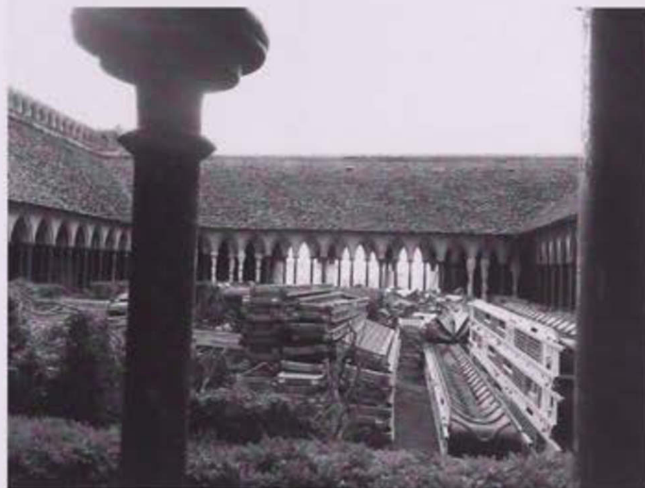
Installation du chantier en janvier 2017. Photo Françoise Denis
