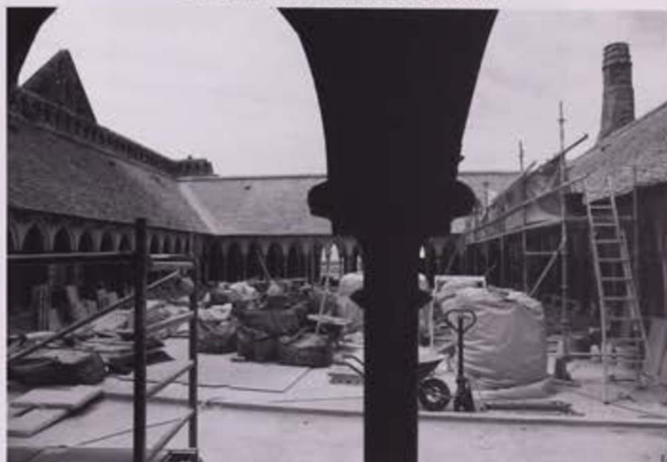
Chantier du cloître en juillet 2017 - Cliché H. Decaens
