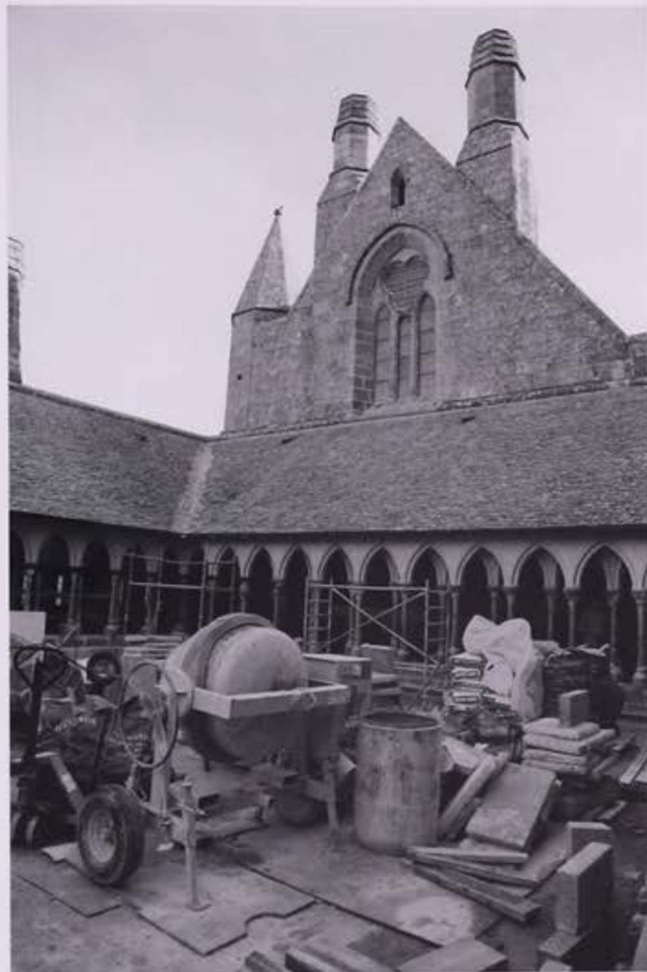
Etat du chantier du cloître le 23 septembre 2017. Cliché H. Decaëns.
