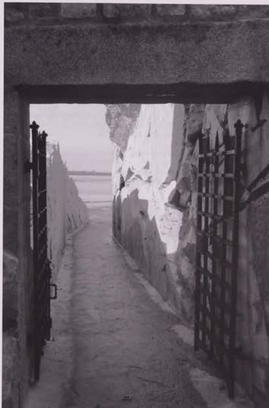
Cheminement aménagé dans les rochers pour accéder au Mont lorsque la porte de l'Avancée est submergée.
