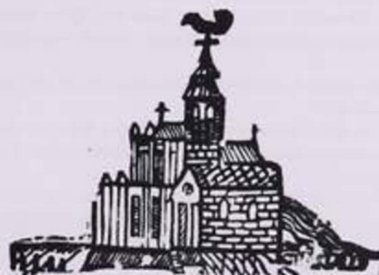
Bois gravé (fin du XVI e siècle ?) montrant un état précédent de la couverture de la tour de croisée.
