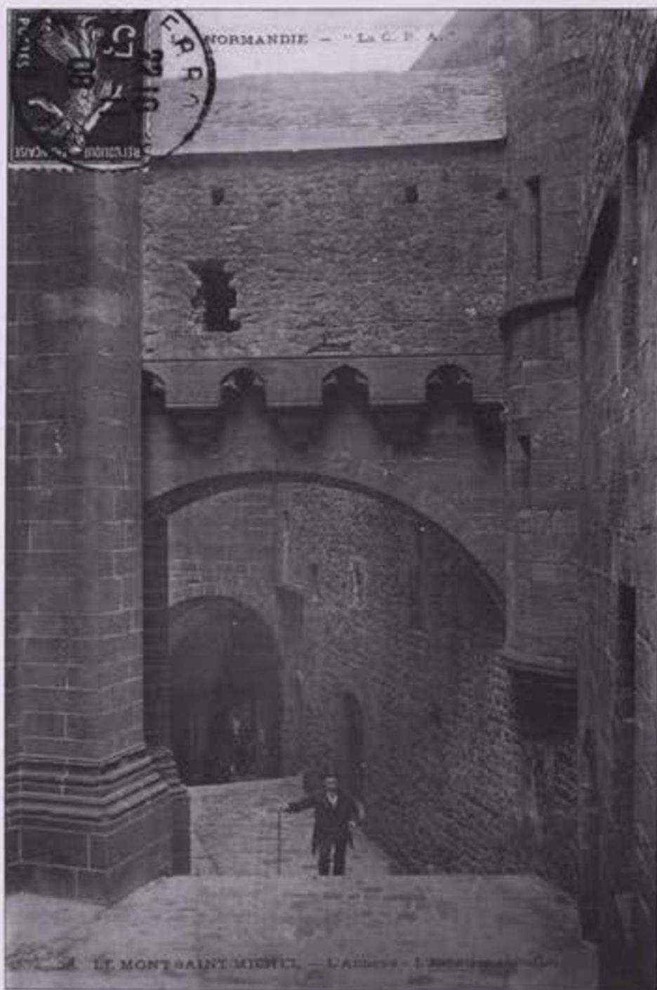
Le pont de pierre enjambant les Grands Degrés pour faire communiquer les logis abbatiaux et la crypte des Gros Piliers. Carte postale ancienne, vers 1905. Coll. H. Decaëns.
