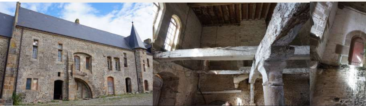
Etat actuel du bâtiment
