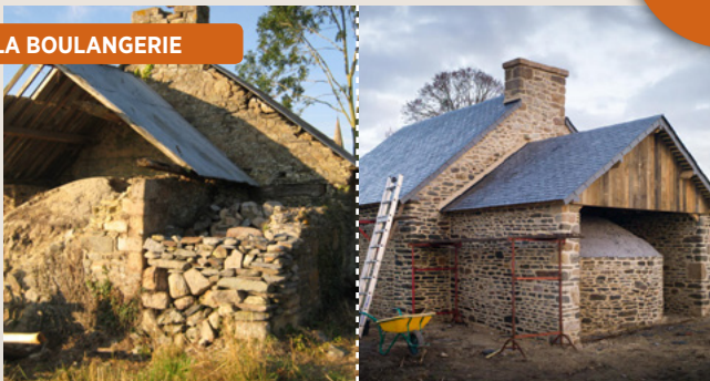
Restauration complète du bâtiment de la boulangerie aujourd'hui transformé en petit gîte.
